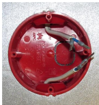
Рисунок 4. Установка монтажной коробки и подвод кабелей.
