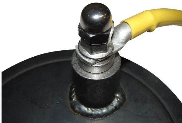
Рисунок 4. Подключения кабеля заземления к контакту **КЗ-МК-10** с помощью наконечника 25-10-8
