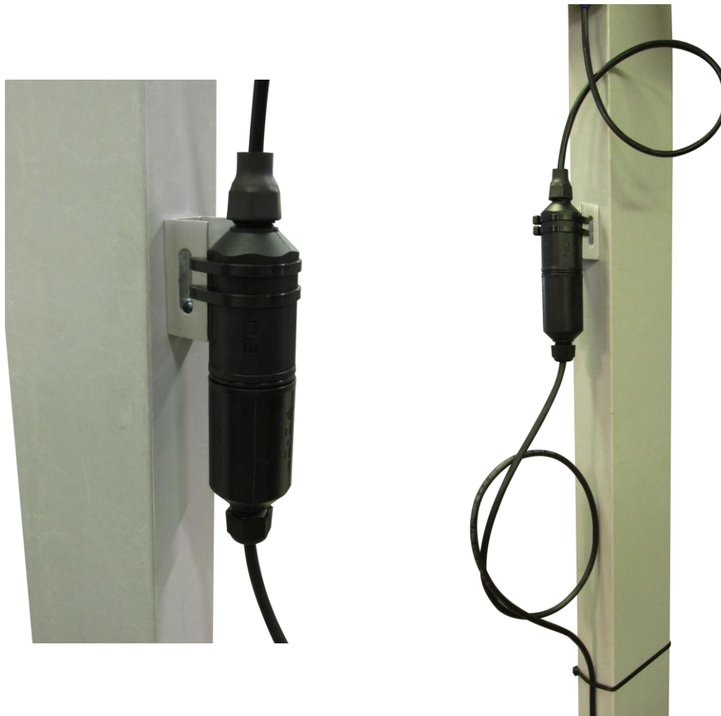
Рисунок 4. Основание монтажное OM1 KHY-2 с установленным устройством защиты Commeng ODU-Protect OD .
